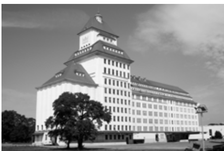
Mühlenturm in Wurzen (Foto: R. Bein)
