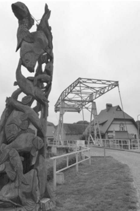
Klappbrücke in Altfriesack (Foto: J. Weihmann)
