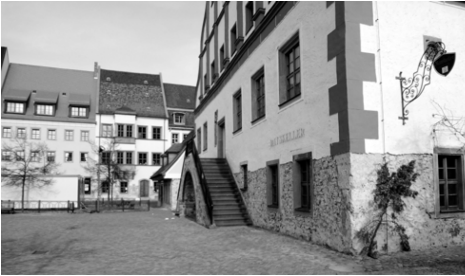
Hochwasserspuren in Grimma (Foto: R. Bein)
