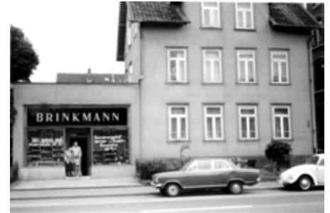
Kastanienallee 63, Ende der 1920er Jahre wurde der Anbau fertiggestellt, dort wurde das Schuhgeschäft 1929 eingerichtet (Foto: D. Krause-Hotopp)
