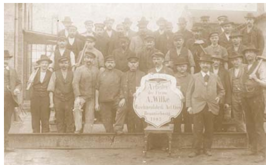
Arbeiter der Firma Wilke
